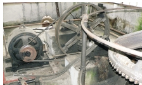
Obnova zastaralé technologie MVE snižuje ztráty a zvyšuje produkci. Foto: EkoWATT
