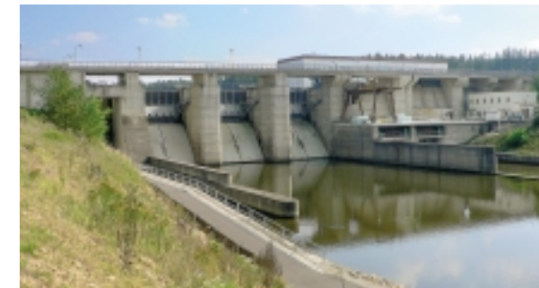
Malá vodní elektrárna Hněvkovice s výkonem 9,6 MW. Foto: EkoWATT
