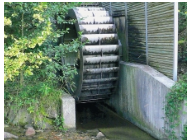
Malé spády lze využít pomocí vodního kola. Foto: EkoWATT
