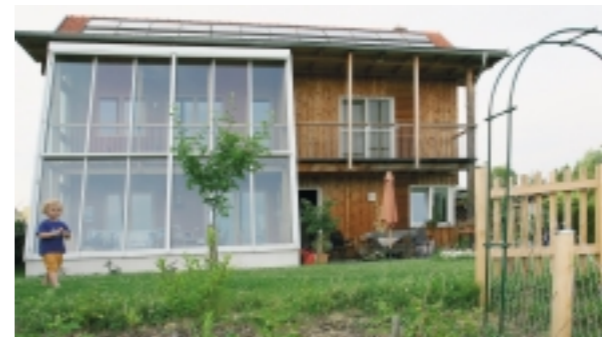
Dodatečně přistavěná nevytápěná zimní zahrada zvětší prostor domu a může snížit jeho spotřebu tepla. Foto: EkoWATT
