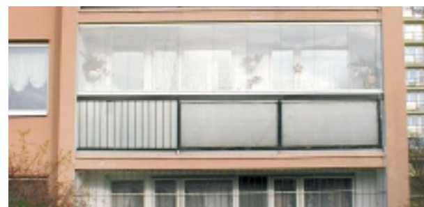
Zasklení lodžií. Foto: EkoWATT
