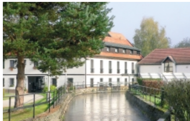
Rekreační objekt vytápěný tepelným čerpadlem, které ochlazuje říční vodu v náhonu malé vodní elektrárny. Foto: EkoWATT
