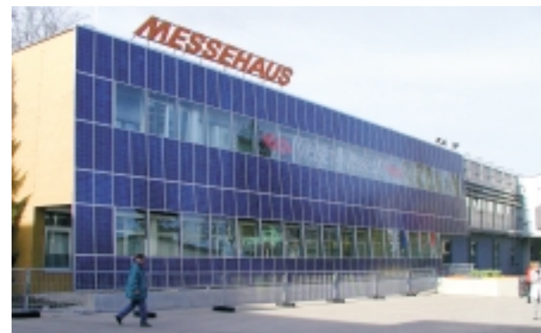
Fasáda z fotovoltaických panelů. Foto: EkoWATT
