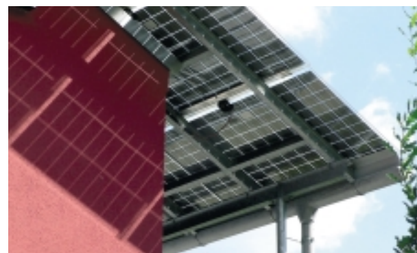
Fotovoltaické panely integrované v prosklení. Foto: EkoWATT
