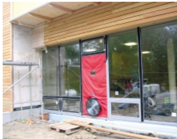
Blower-door test. Foto: Ekologický institut Veronica
