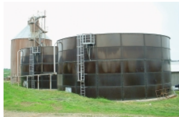
Kontinuální systém na zpracování kejdy. Foto: EkoWATT
