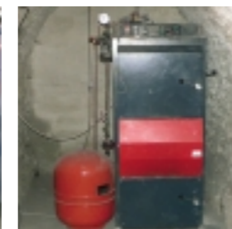
Náhrada kotle na uhlí kotlem na dřevo. Foto: EkoWATT
