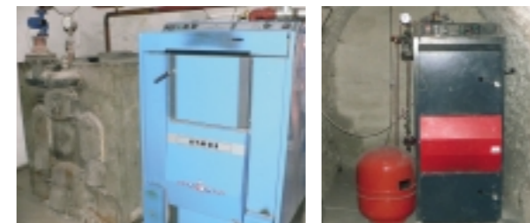
Náhrada kotle na uhlí kotlem na dřevo. Foto: EkoWATT
