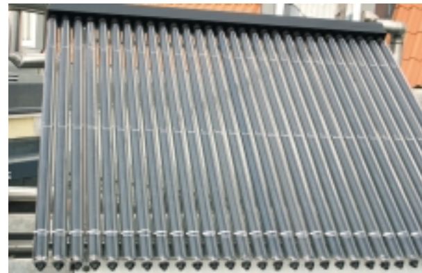
Kolektor z vakuových trubíc. Foto: EkoWATT
