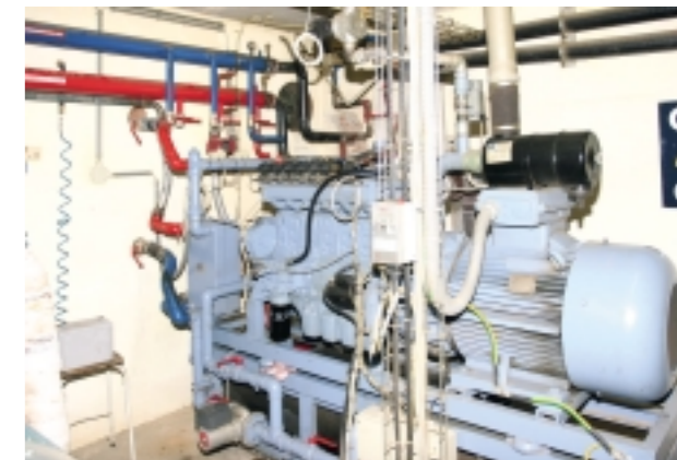
Základem mnoha kogeneračních jednotek je upravený motor z automobilu, na snímku bez protihlukového krytu. Foto: EkoWATT
